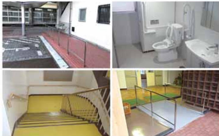
旧片浜小学校において手すりの設置やトイレ改修、駐車場整備などを実施
