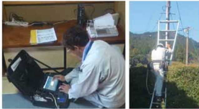
申し込みをされた家庭で光回線の引き込み工事を行う業者
