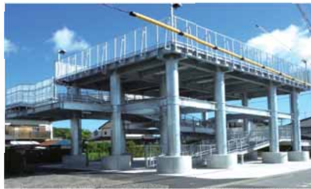
Fブロック(市営住宅東海団地跡地)に完成した津波避難タワー
