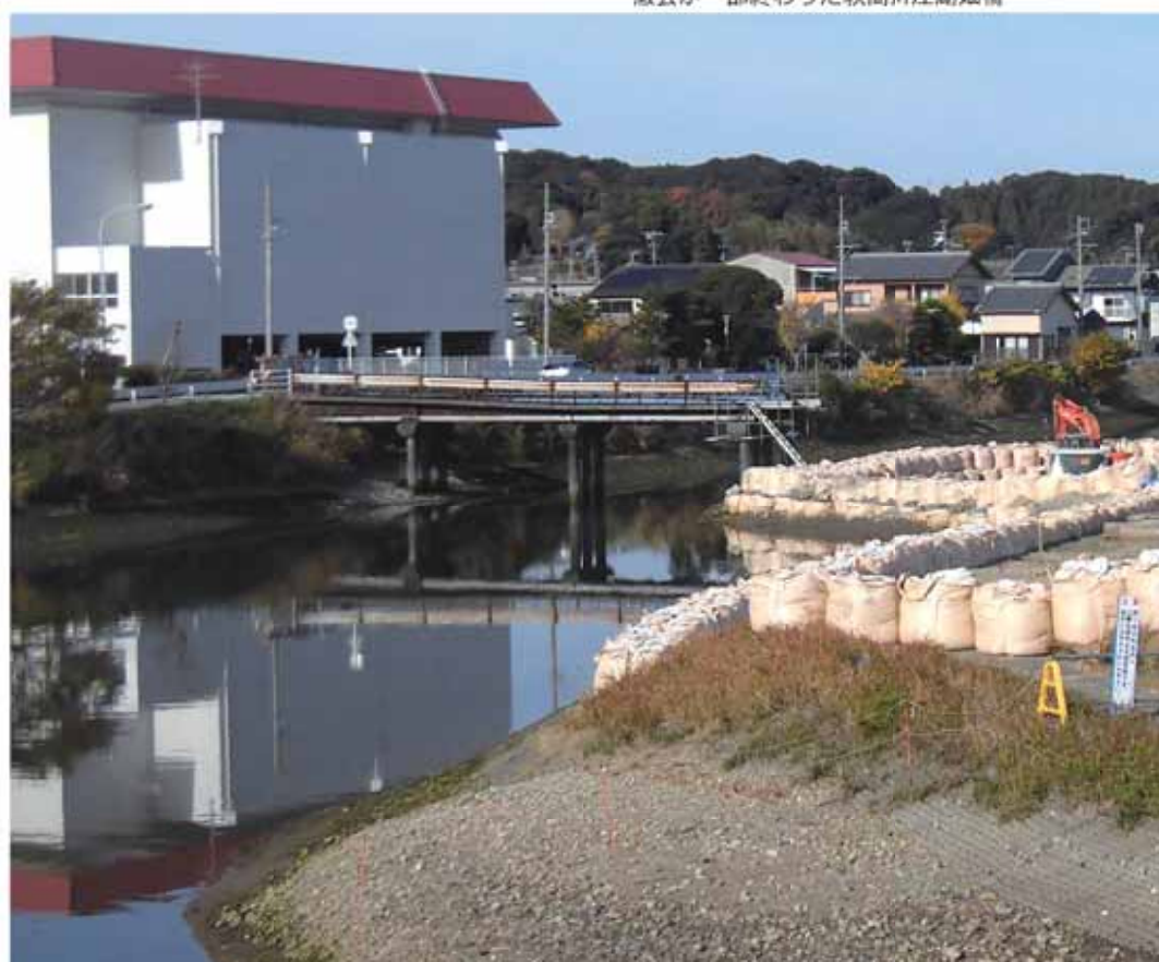
撤去が一部終わった萩間川江湖畑橋
