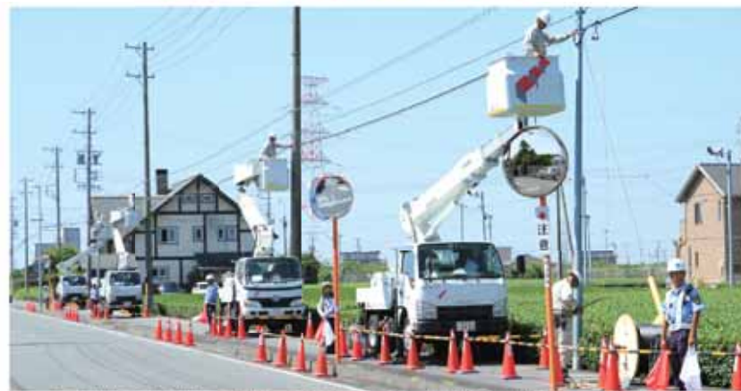
未整備地区(坂部・勝間田・牧之原・萩間・地頭方)に光ファイバー網を整備
