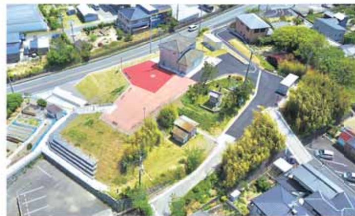
相良・福岡地内に完成した金比羅山防災公園
