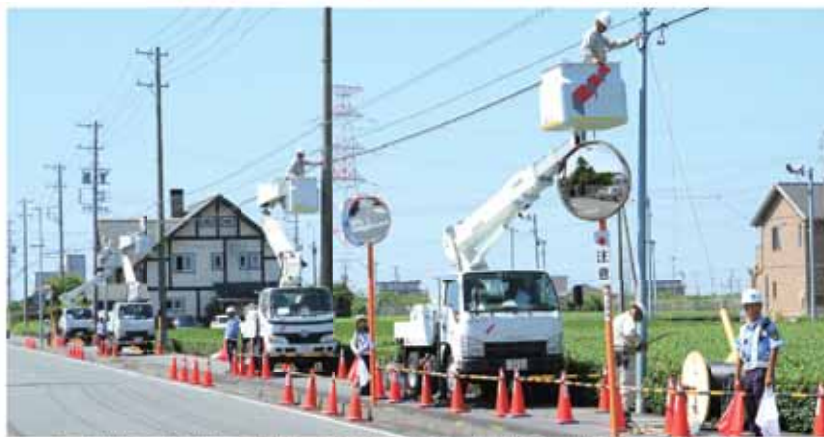
未整備地区(坂部・勝間田・牧之原・萩間・地頭方)に光ファイバー網を整備
