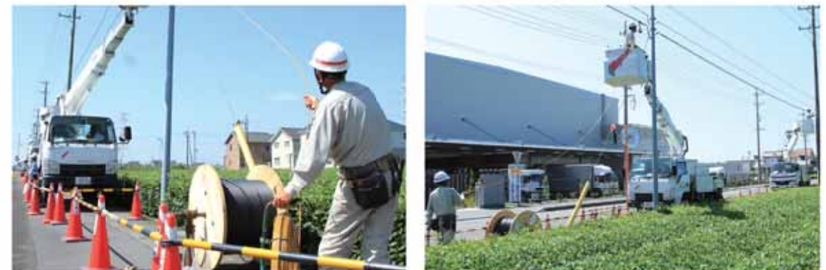
光ファイバ網を電柱に張り巡らせていく
