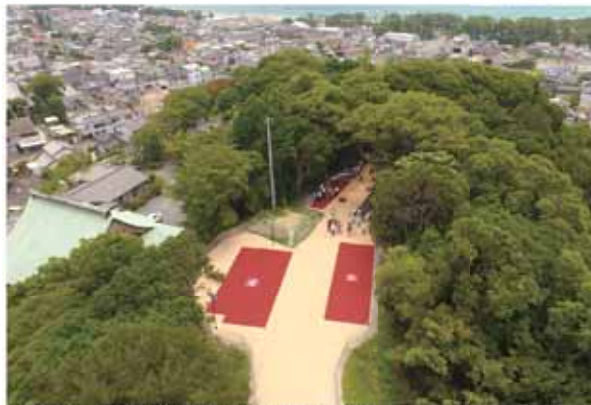
完成した小堤山公園南側山頂の波津2号津波避難地(相良地区)
