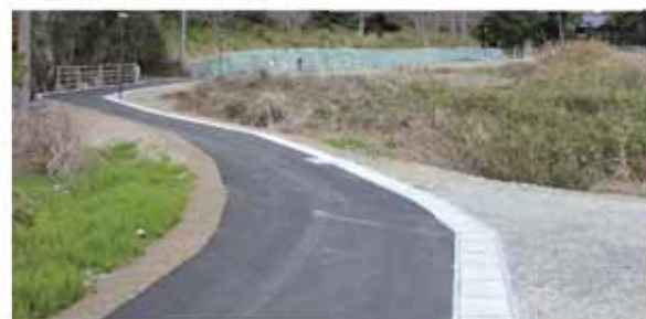
完成した避難路
