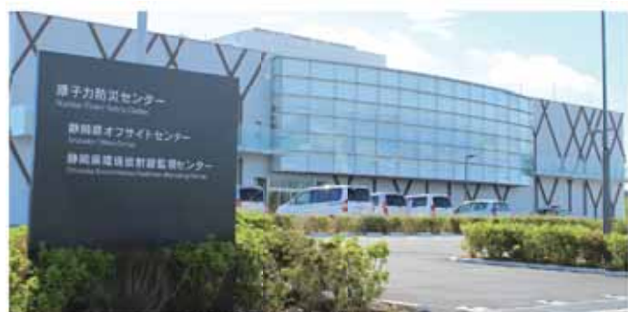
富士山静岡空港西側に完成した県のオフサイトセンター
