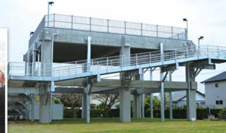
1ブロック (細江区東慶林公園) 津波避難タワー 収容人数 (405人) 施設面積 (244m) 高さ (9.50m) 構造 (PCコンクリート造)
