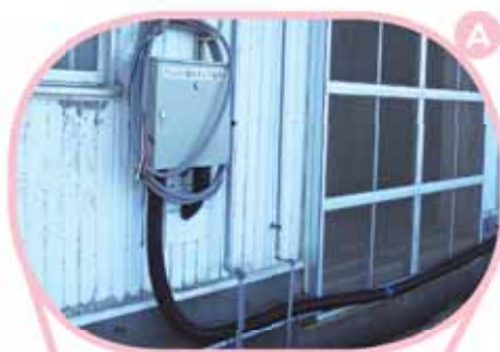
工場の外壁に商用動力電源設備を整備
