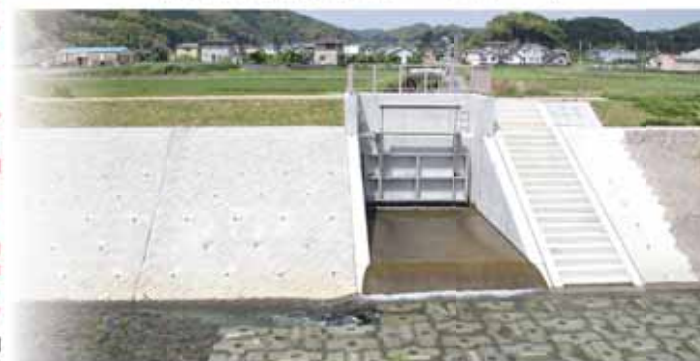
流末部に完成した樋門とオートゲート
