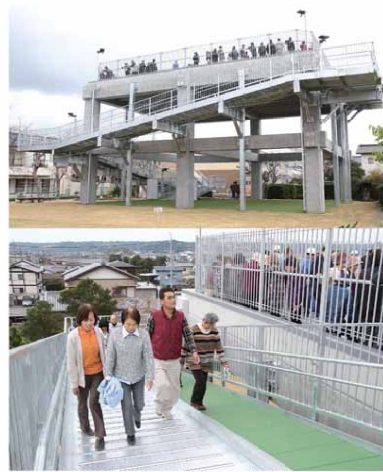
完成した細江区東慶林公園内の津波避難タワーで避難訓練
