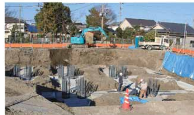
旧静波西保育園跡地で進む工事の様子
