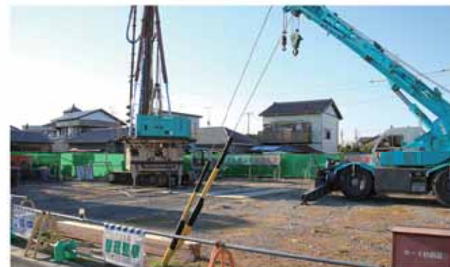
市営住宅東海団地跡地で進む工事の様子
