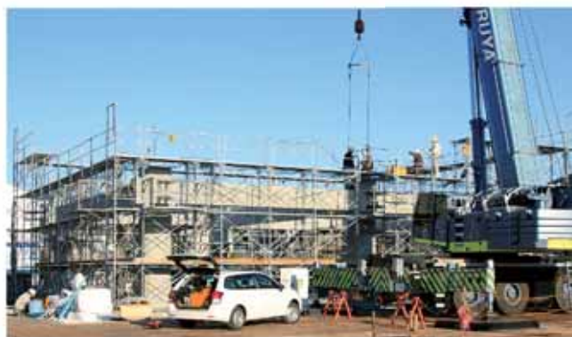
東慶林公園で進む工事の様子
