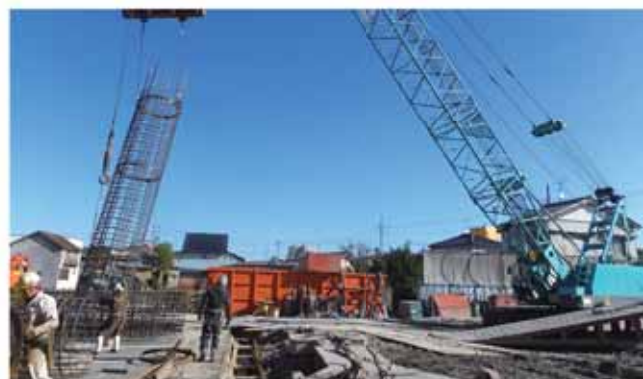
本通り駐車場で進む工事の様子
