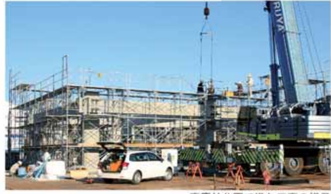
東慶林公園で進む工事の様子
