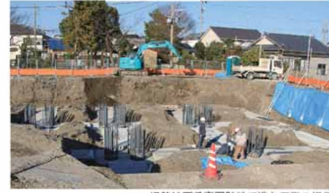
旧静波西保育園跡地で進む工事の様子
