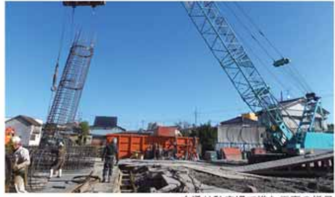
本通り駐車場で進む工事の様子
