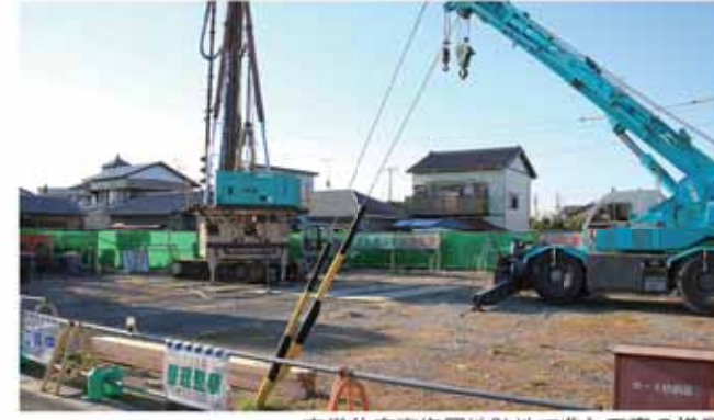
市営住宅東海団地跡地で進む工事の様子
