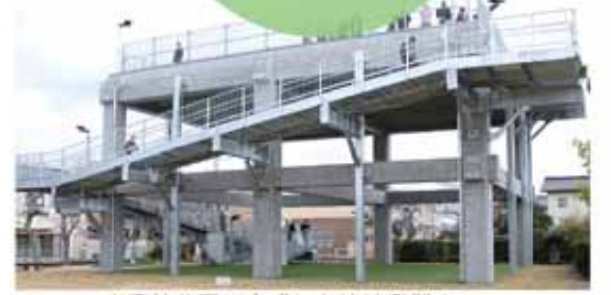
東慶林公園に完成した津波避難タワー
