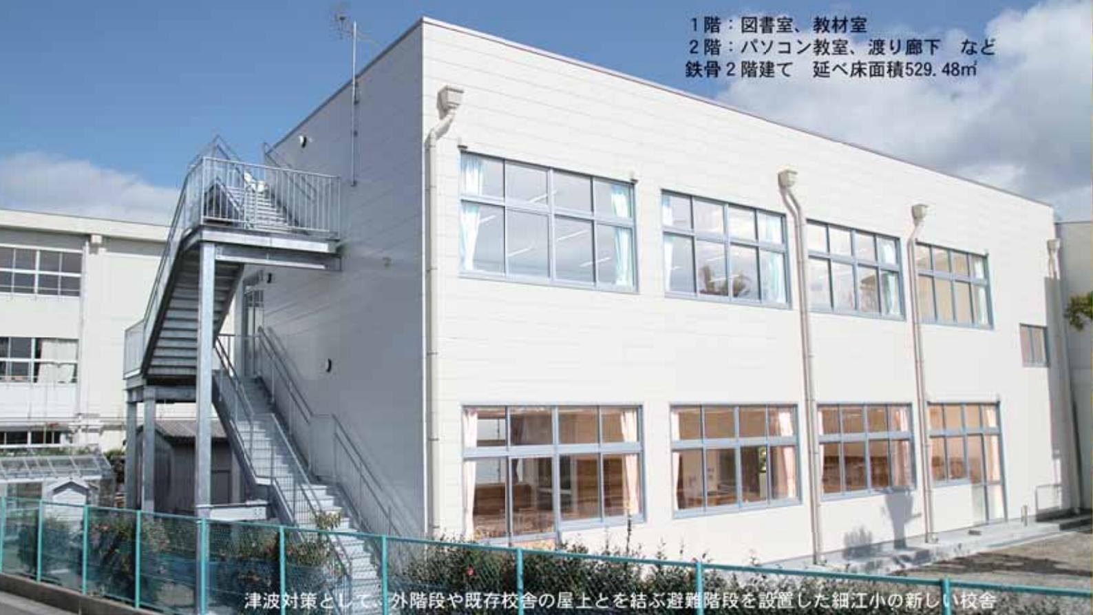
津波対策として、外階段や既存校舎の屋上とを結ぶ避難階段を設置した細江小の新しい校舎
