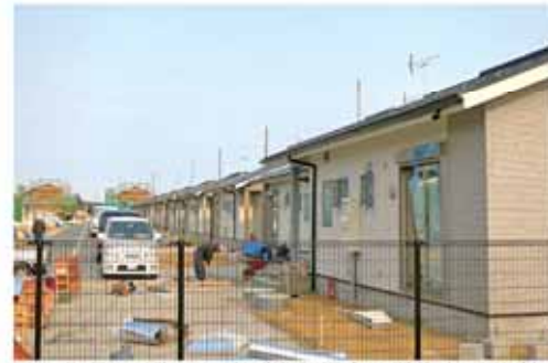
3月入居を目指し工事が進む災害公営住宅（戸建）
