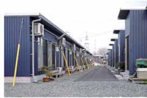
仮設住宅の外観
