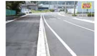
▲安全に津波避難できる避難路
