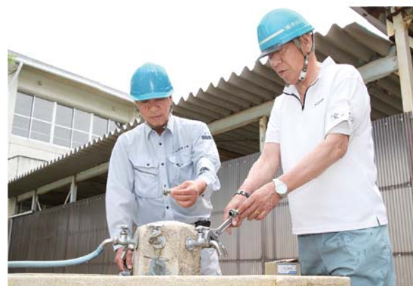
細江小の校庭で水道の蛇口を点検する水道事業者
