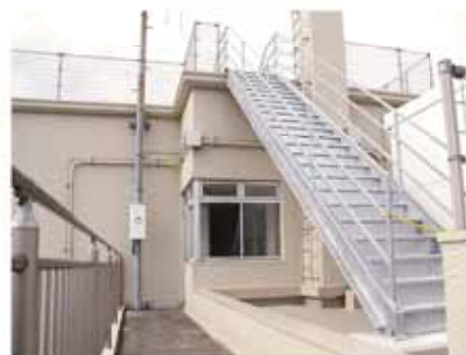
新たに設置した屋上への避難階段
