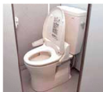
全館のトイレを温水洗浄便座の洋式に替えました
