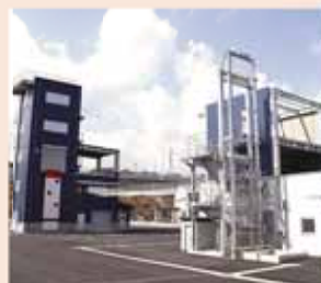
訓練棟・訓練施設
