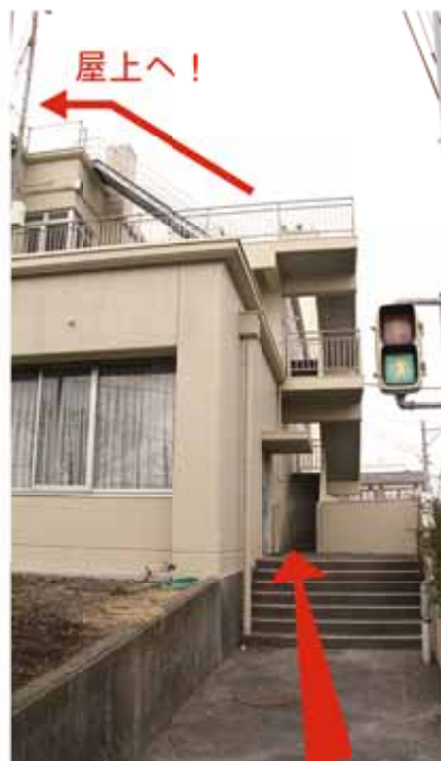
避難階段は文化センターの東側、交差点の入口から上れます
