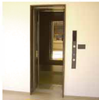
3階までのエレベーターを設置
