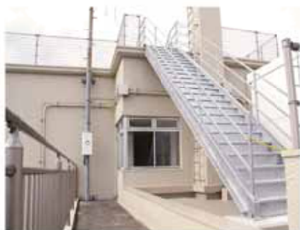
新たに設置した屋上への避難階段
