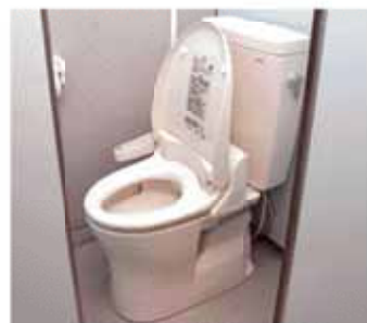
全館のトイレを温水洗浄便座の洋式に替えました
