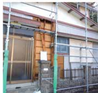
筋交を入れて耐震補強する住宅
