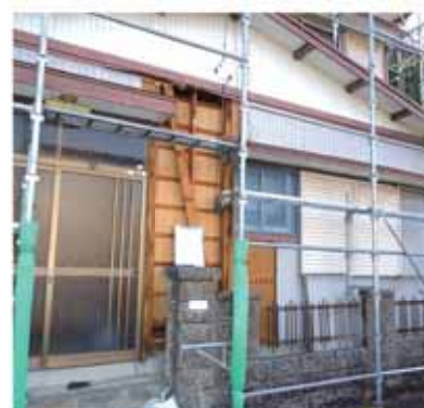
筋交を入れて耐震補強する住宅
