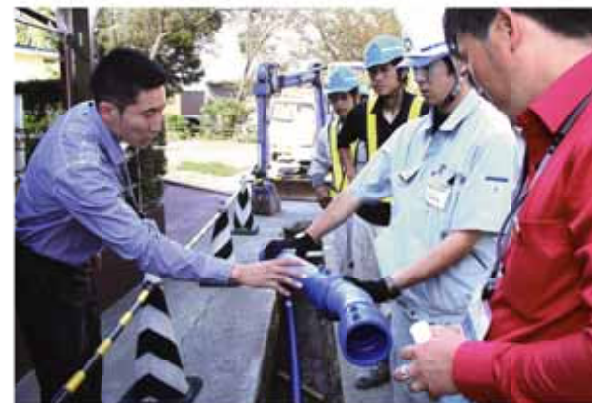
工事について、市職員に質問する研修生（左端と右端）
