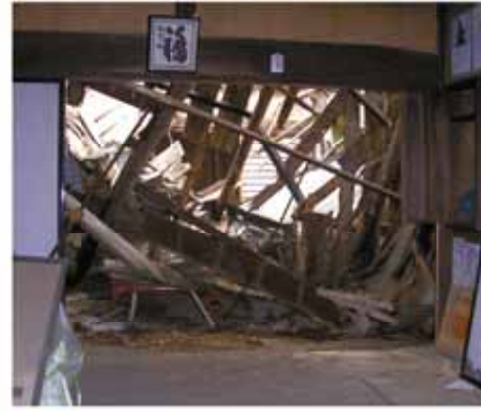
平成21年8月の地震で半壊した家屋
