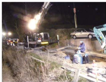
凍てつく寒さの中で行われた夜間作業
