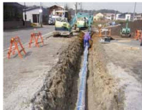
今後も計画的に施設整備を行っていきます （細江1号幹線老朽管改良工事）
