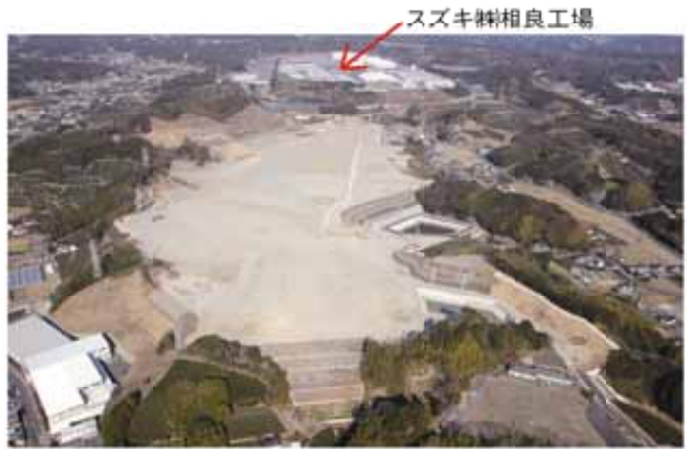
造成が完了した工業用地の全景(平成23年12月末撮影)
