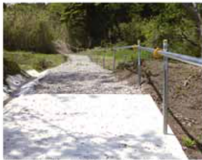
地区で整備した避難路（地頭方区）
