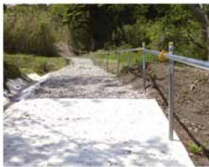
地区で整備した避難路（地頭方区）
