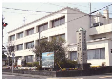
榛原文化センター会館棟
