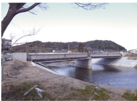
工事中の山手線深谷橋
