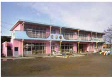
耐震補強工事が完了した地頭方保育園の園舎
