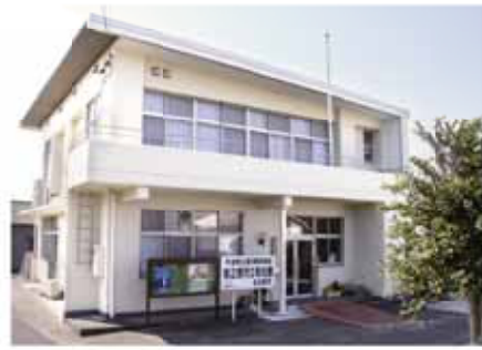
耐震工事が完了した和光館
