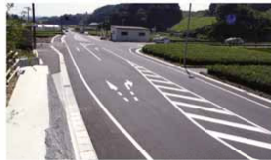
改良工事を実施した東萩間西原線
