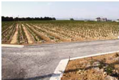
区画整理された茶園（坂部地区）
