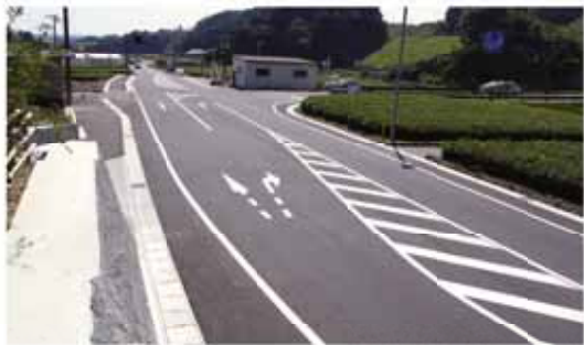
改良工事を実施した東萩間西原線
