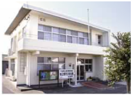
耐震工事が完了した和光館
