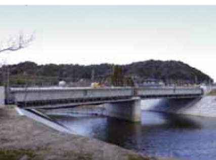
平成24年3月開通予定の山の手幹線の深谷橋
