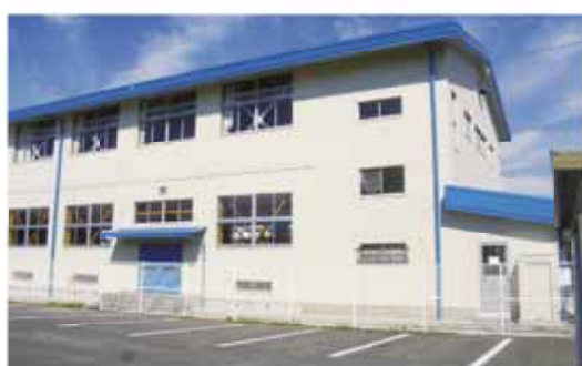
耐震化工事が完了した相良中学校格技場
