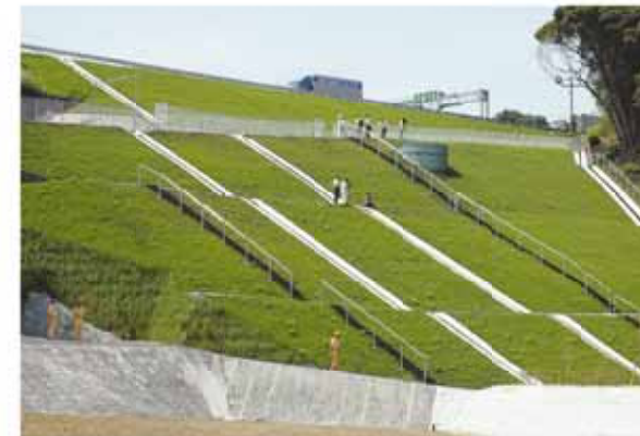
↑東海地震を耐えられる構造に改良された法面。
