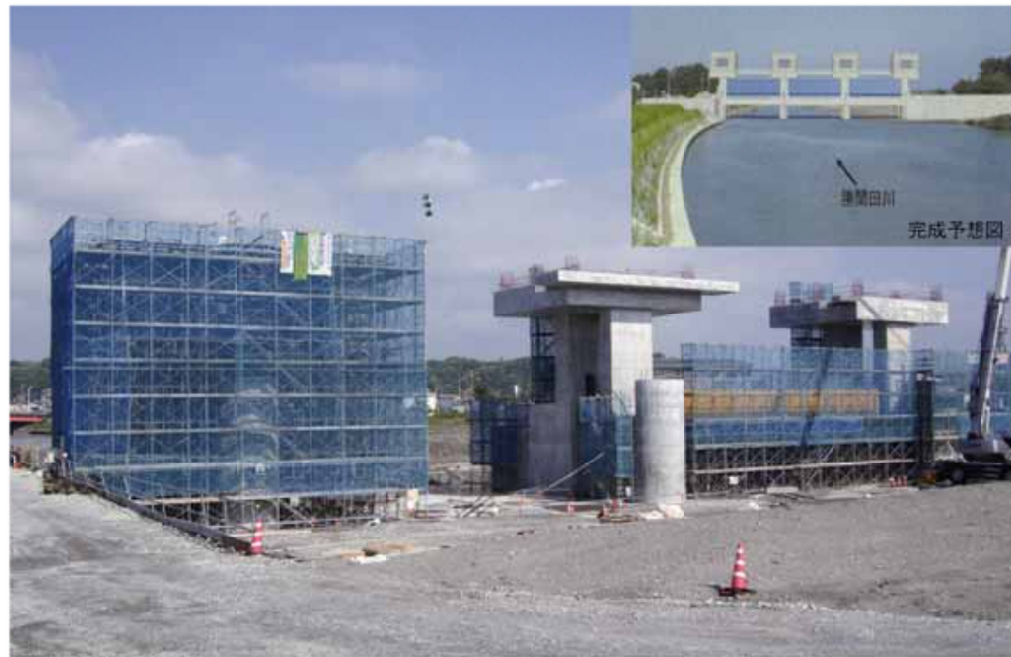
建設中の勝間田川水門
