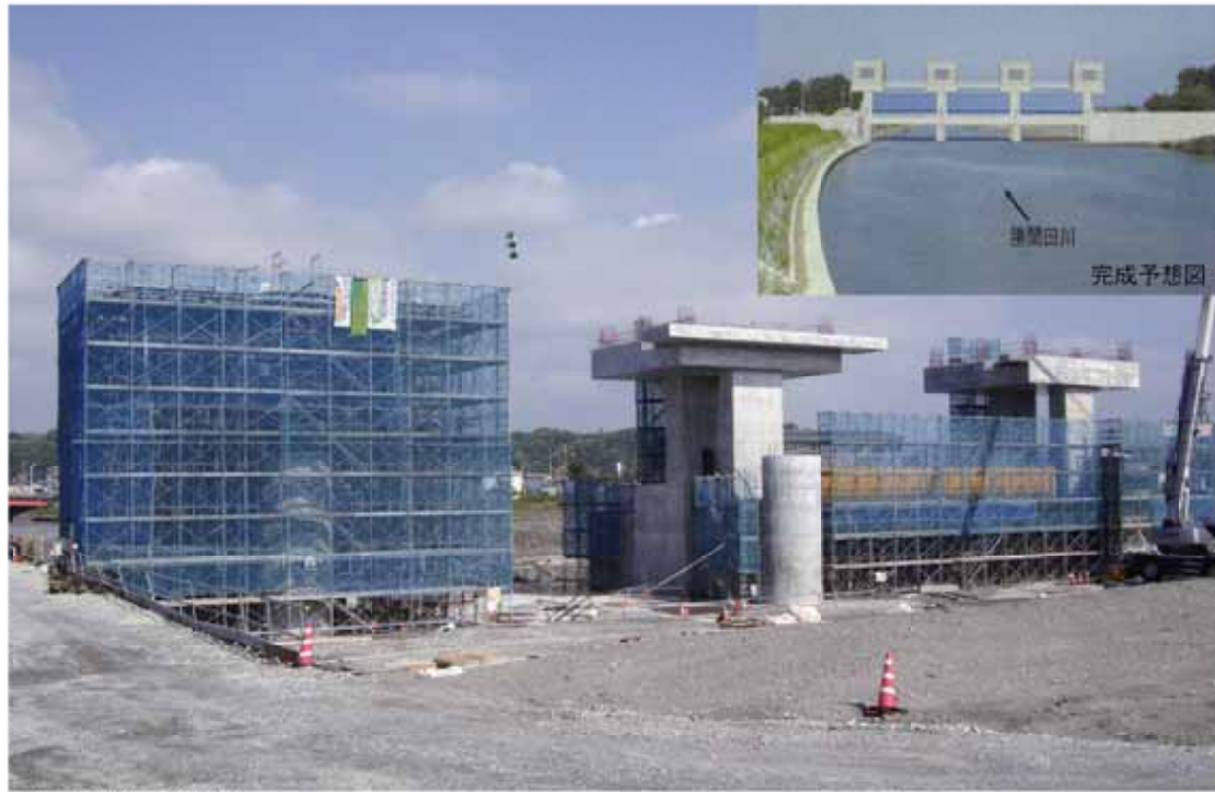
建設中の勝間田川水門
