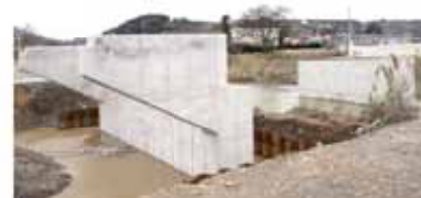
生活・幹線道路の整備(写真は深谷橋)
