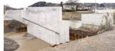
生活・幹線道路の整備(写真は深谷橋)
