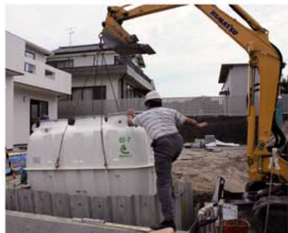
合併処理浄化槽の設置状況
