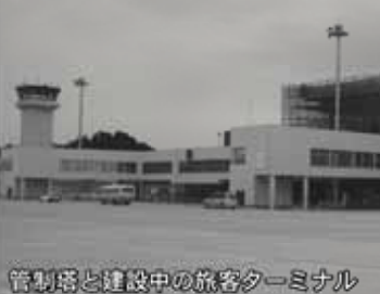
管制塔と建設中の旅客ターミナル
