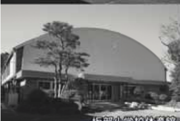
坂部小学校体育館
