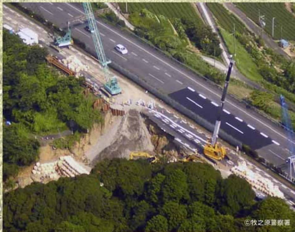
▲駿河湾を震源地とする地震が発生し、震度6弱の揺れが牧之原市を襲いました。市内では屋根瓦の落下、断水、東名高速道路のり面の崩落など、多くの被害がありました/8月11日
