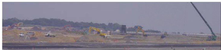
連日大型重機が活躍し、工事が進む滑走路
