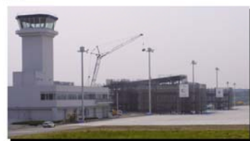
着実に工事が進む旅客ターミナルビル（写真奥。手前は完成した管制塔）
