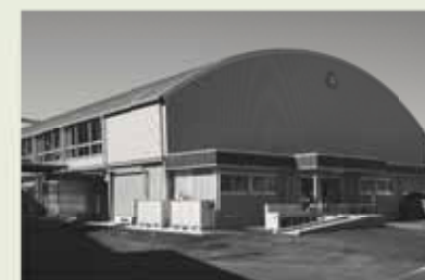
萩間小学校体育館
