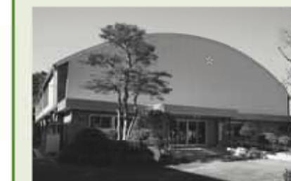
坂部小学校体育館
