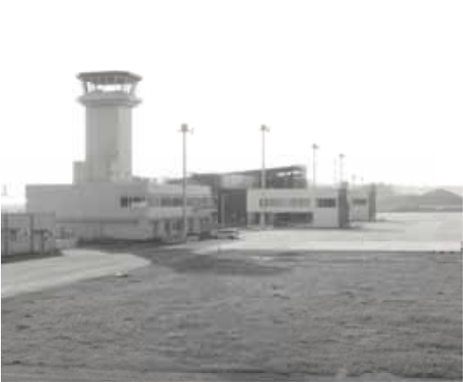
工事が進む空港ターミナルビル
