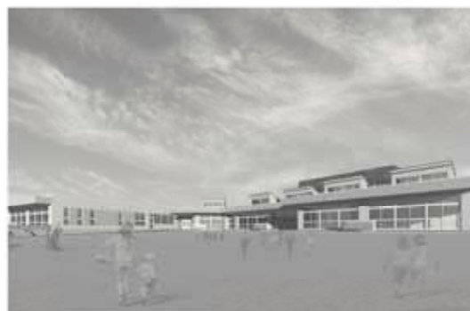
建設地 相良総合センターい〜ら隣接地 構造 鉄筋コンクリート造平屋建て 延べ床面積 1,043.38平方メートル
