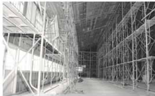
③「子育て徳育」 耐震化工事が進む川崎小学校体育館
