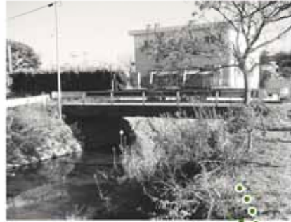
【着手前】旧新戸川橋
