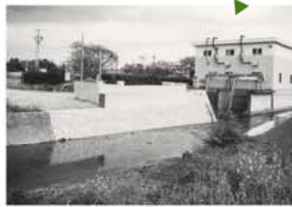
【着手後】橋の下部が幅員12mに拡幅され完成。前後の道路も併せて拡幅されました
