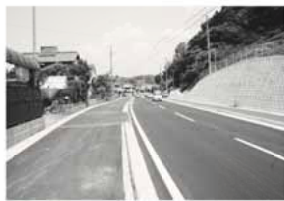
【着手後】広い歩道が整備され、児童生徒の安全が確保された仁田口付近
