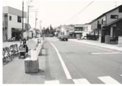
【着手後】歩道が付いた内山交差点（静波）付近
