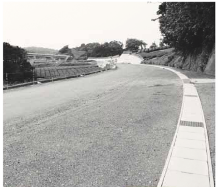
【着手後】拡幅が終了した須々木大溝線。左奥に見えるのは150号バイパス。アスファルト舗装は、今年度行われます
