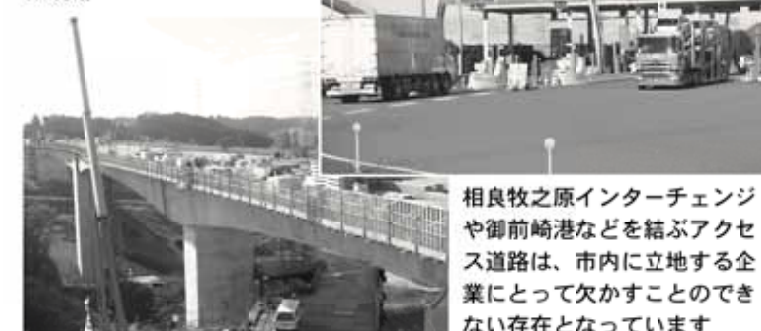
右／相良牧之原インターチェンジ 下／国道473号バイパス建設現場
