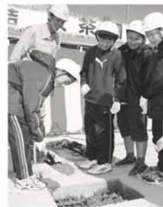
最後の工事部分にコンクリートを流し込む児童
