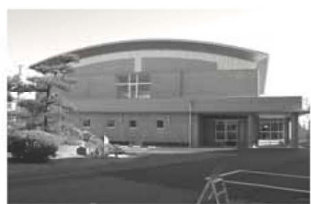
完成した細江小体育館。光を多く取り入れるため、上部には多くの窓を設置しました
