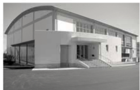
雨水を地下の貯水槽に貯め、トイレなどに利用している牧之原中体育館
