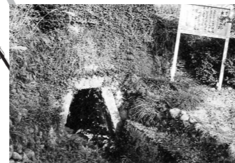
坂口谷川は水量が安定せず、流域地域では水田かんがいに大変苦労しました。そのため、本間賢三らが尽力し、明治9年に大井川から用水を引き込む大井川用水(本間用水)を完成させました
