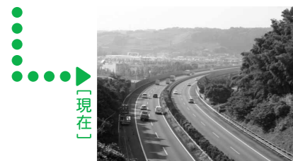
[写真上] 建設の進む東名高速道路。坂部地域には64基の橋脚が立てられ、高架橋の上を車が通る方式がとられました。 [写真下] 現在は、「日本経済の動脈」として、多くの車が往来しています。
